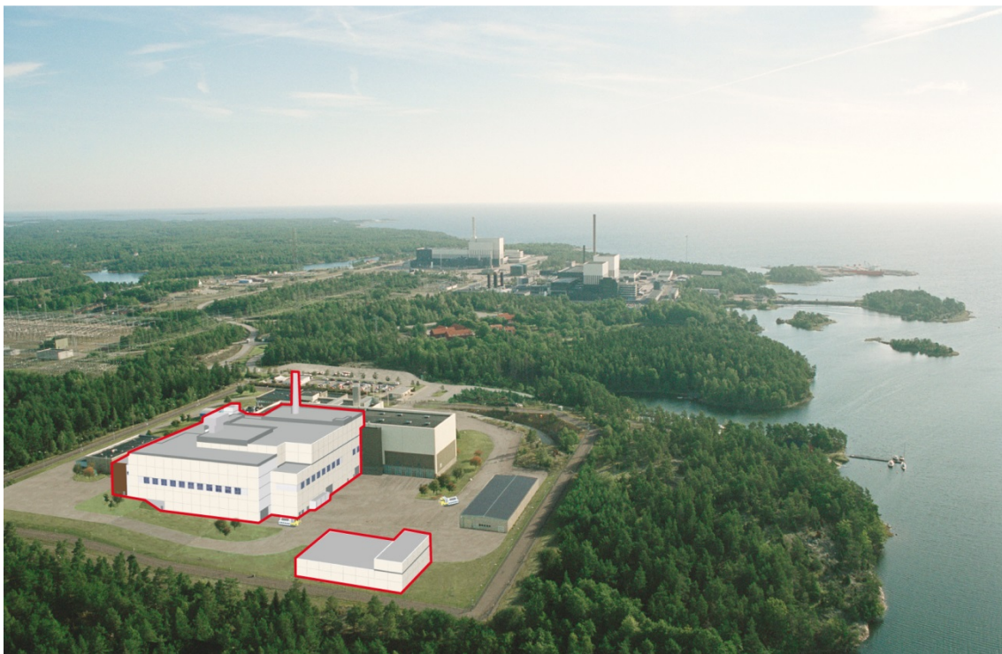
Kuva S-6. Kapselointilaitos sijoitetaan Clabin välittömään läheisyyteen ja molempia laitoksia käytetään yhtenäisenä laitoksena, joka saa nimekseen Clink. Punaisella merkitty osoittaa fotomontaasin.
