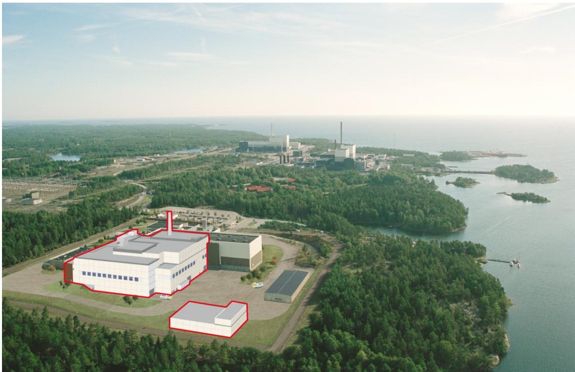
Abbildung S-6. Der Anlagenteil für die Verkapselung wird direkt neben Clab angeordnet und die beiden Einrichtungen sollen als eine integrierte Anlage namens Clink betrieben werden. Die rote Umrandung markiert den Teil des Bildes, der eine Fotomontage ist.
